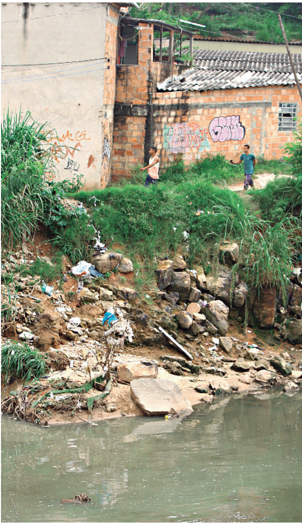
RIBEIRÃO DE ABREU – Córrego do Onça, na região Norte, sofre com lixo depositado em vários pontos
