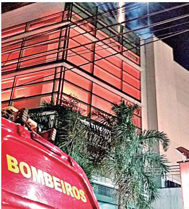
| ONDE – Incêndio ocorreu no segundo andar do shopping |
