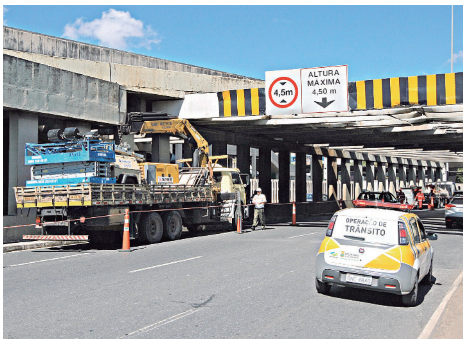
REPARO — Duas das quatro faixas da via ficarão interditadas; obra termina na segunda
