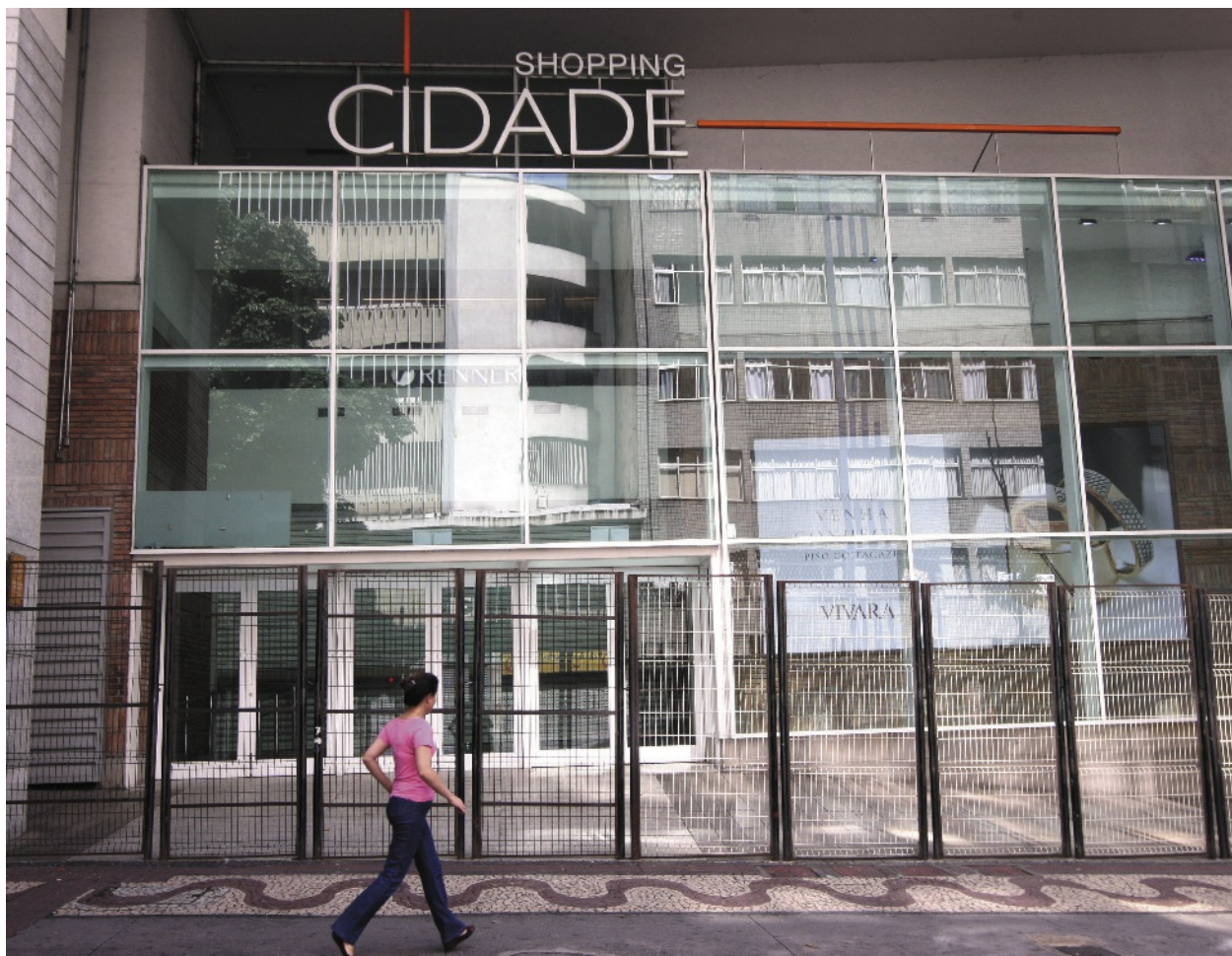
REIVINDICAÇÃO ANTIGA – Plano de reabertura do comércio vai contemplar shoppings centers na fase 1; PBH afirma que protocolos sanitários estão mais rígidos
